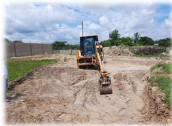
Excavación para mejor terreno natural existente Ebar de Palmar de Varela
