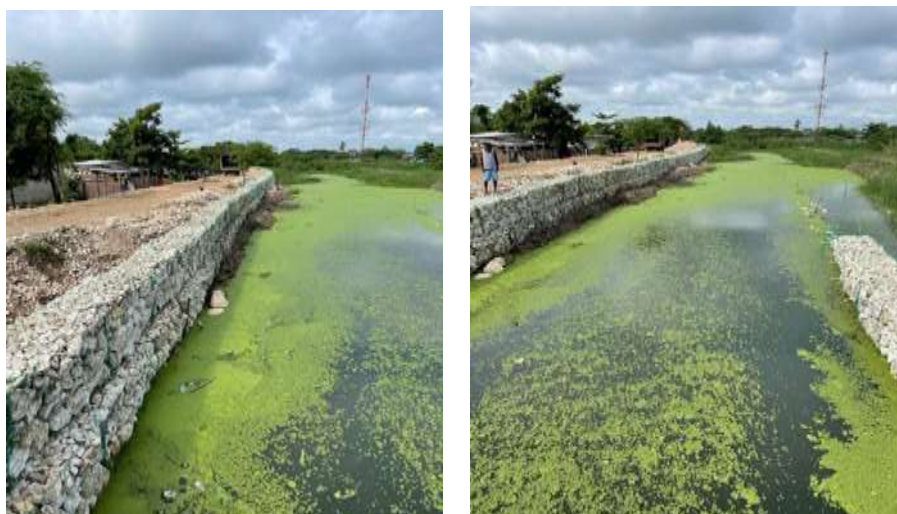
Imagen 24: Construcción de muro de gavión margen izquierda y derecha aguas hacia arriba
