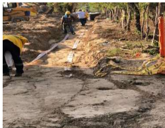
Señalización de tuberías sector Palmar de Varela y Santo Tomás
