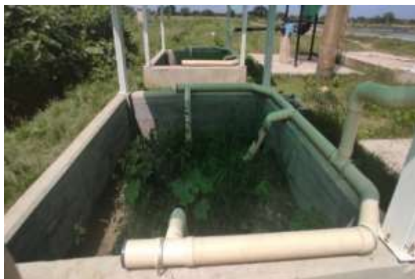
Evaluación del PSMV del municipio de Campo de la Cruz. Dos módulos de lecho de secado de arenas provenientes de los desarenadores. Lugar: EDAR Campo de la Cruz. Fecha: 17 de junio de 2021.
