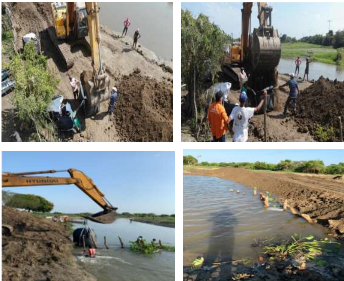
Imágen. Dique provisional en Villa Rosa
