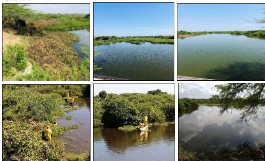
Imagen: Limpieza mecanizada puente Palmar de Varela.
