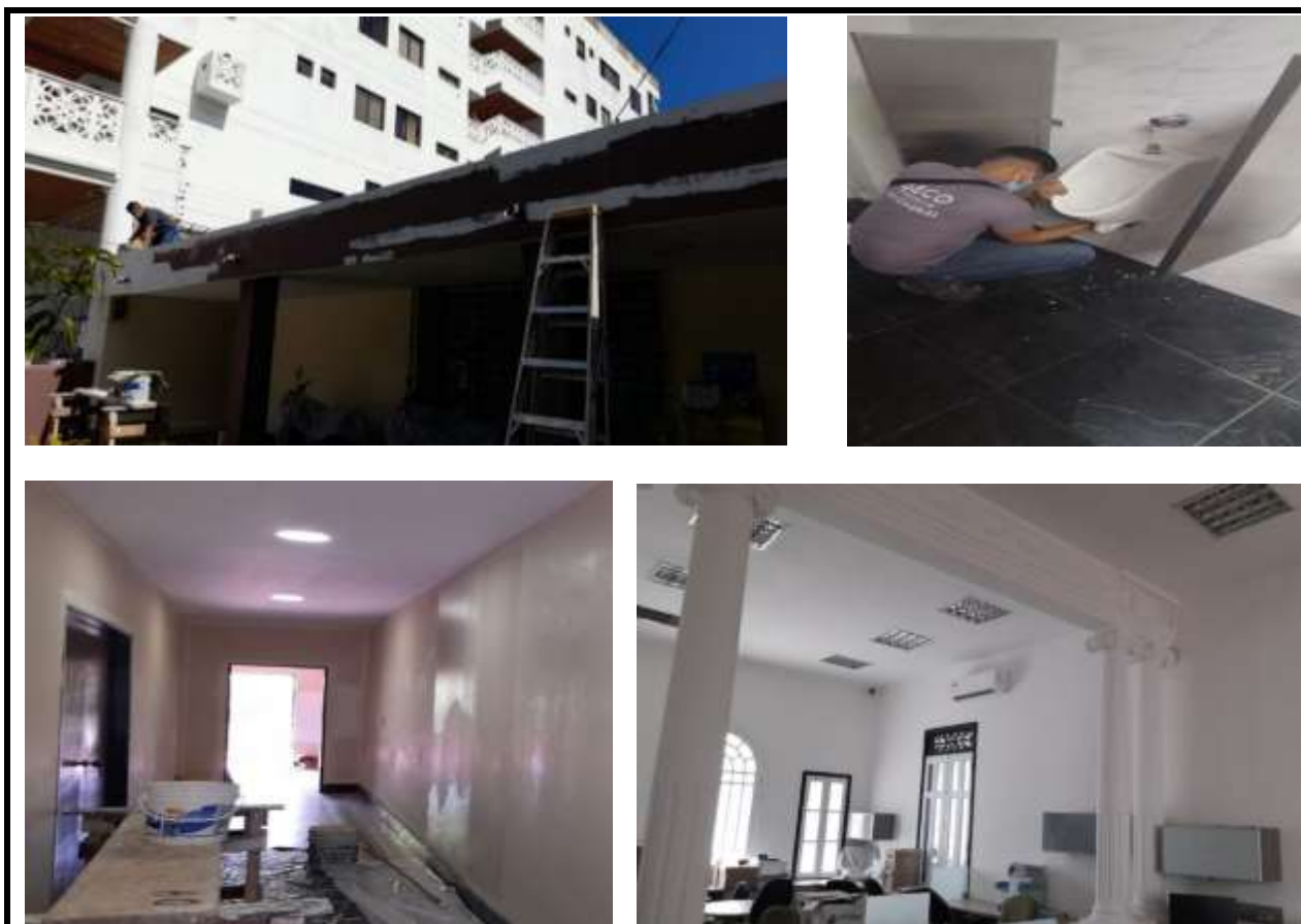
Mantenimiento a instalaciones locativas.
