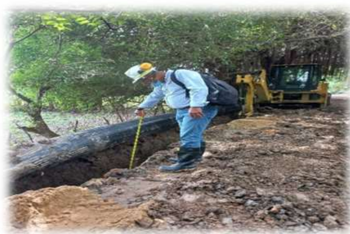
Instalación de tubería PEAD 500 mm en la línea de impulsión PTAR hacia el Rio del K2+630. – K2+916.
