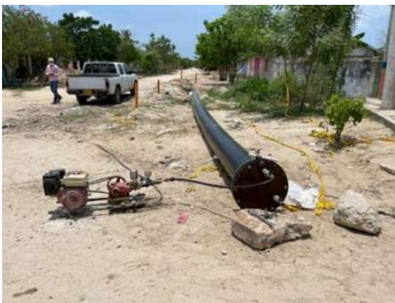
Prueba hidrostática sector Palmar de Varela
