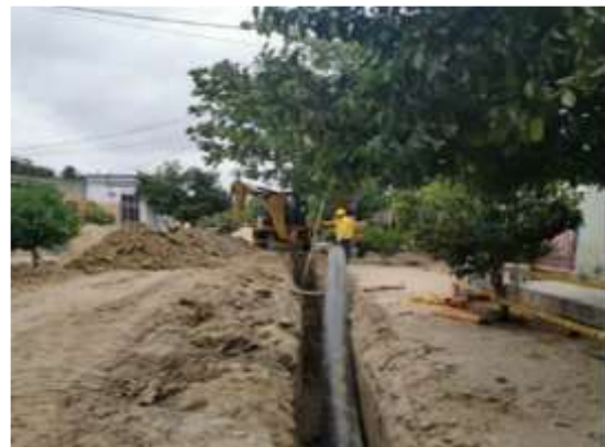
Instalación línea de impulsión municipio de Palmar de Varela
