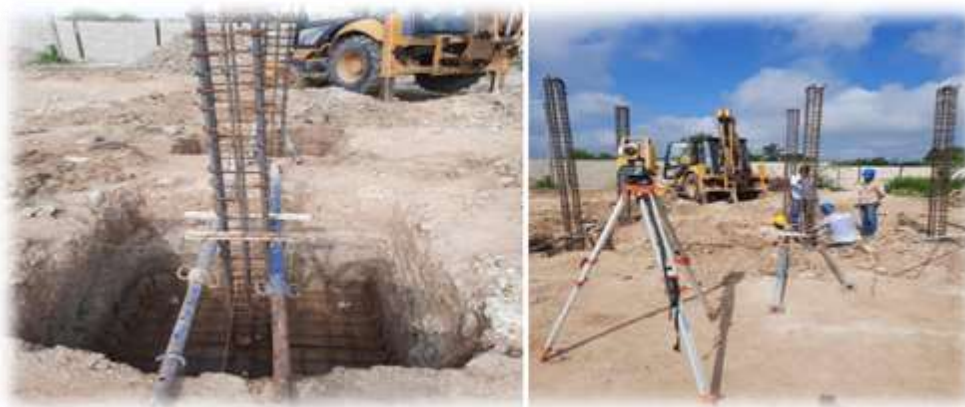
Armado de acero de refuerzo de zapatas y columnas caseta eléctrica Ebar de Palmar de Varela
