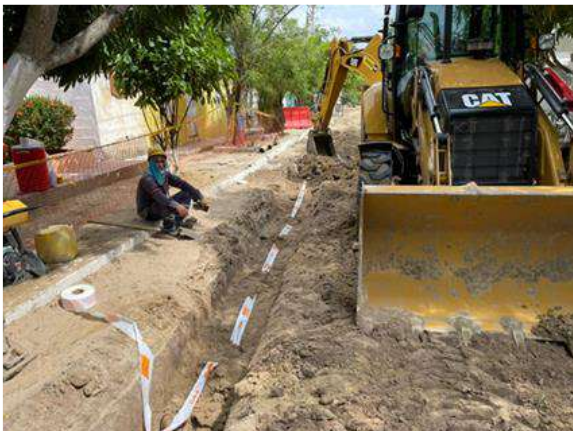
Señalización de tuberías sector Palmar de Varela y Santo Tomás
