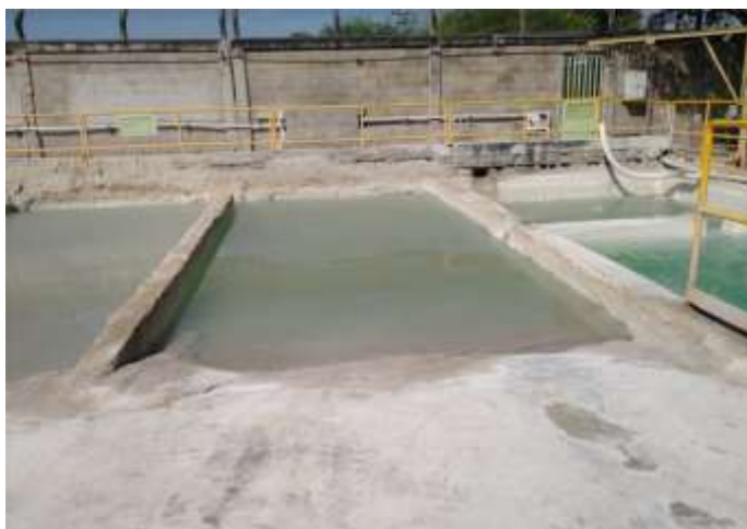
Evaluación de la solicitud de renovación del permiso de vertimientos líquidos presentada por la empresa Concretos Argos S.A. – Planta Soledad. Foto: Sedimentadores Fecha: 23 de febrero de 2021 Lugar: Argos Soledad
