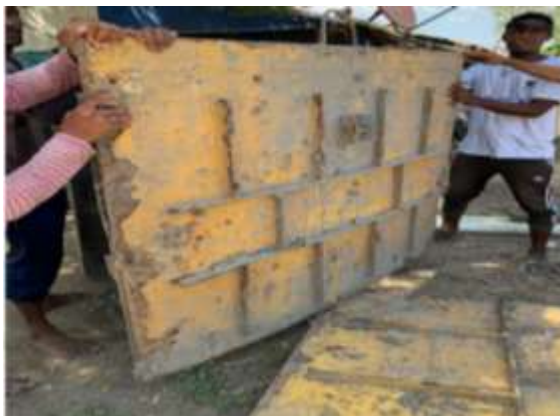
Imágen. Desmonte de compuertas en Villa Rosa
